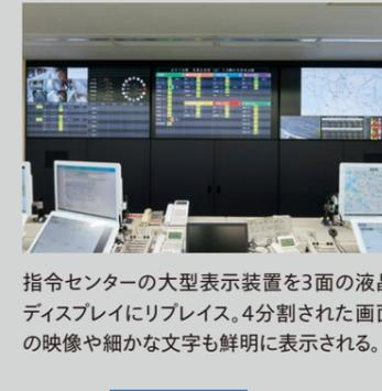
指令センターの大型表示装置を3面の液晶ディスプレイにリプレイス。4分割された画面の映像や細かな文字も鮮明に表示される。
